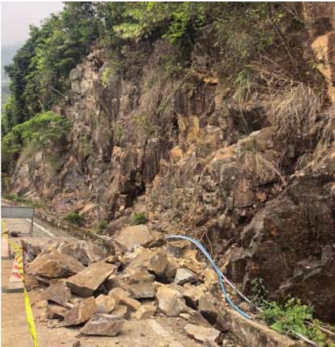
现状边坡照片
