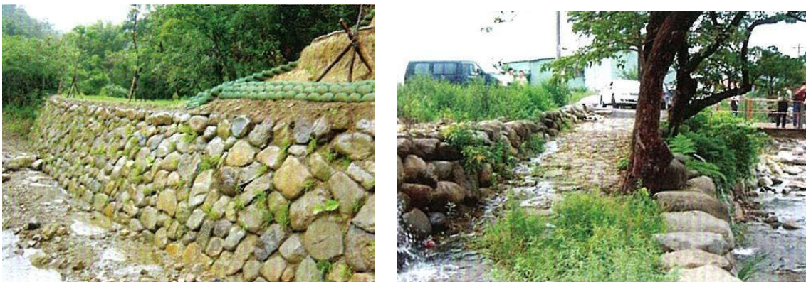
图 5-1 干砌石护岸构造示意图
