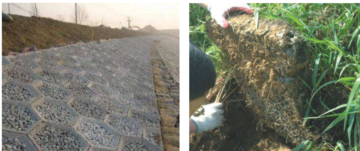
图 6-1 生态混凝土护坡图
