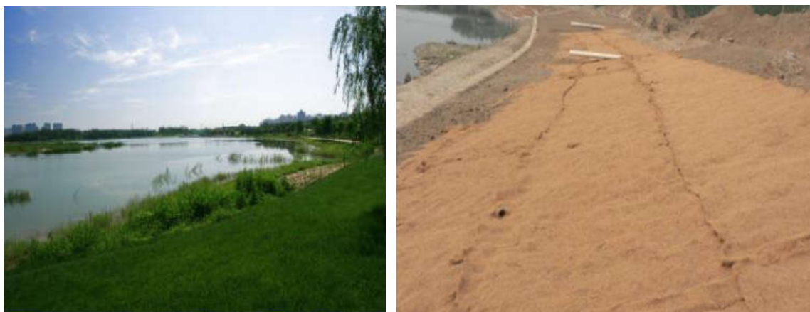
图 11-2 天然麻椰固土毯工程与实例图
