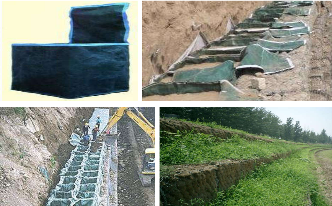
图 14-1 机织有纺土石笼袋工程运用实例图
