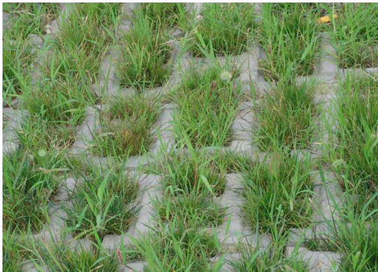
图 8-1 开孔式混凝土砌块图
