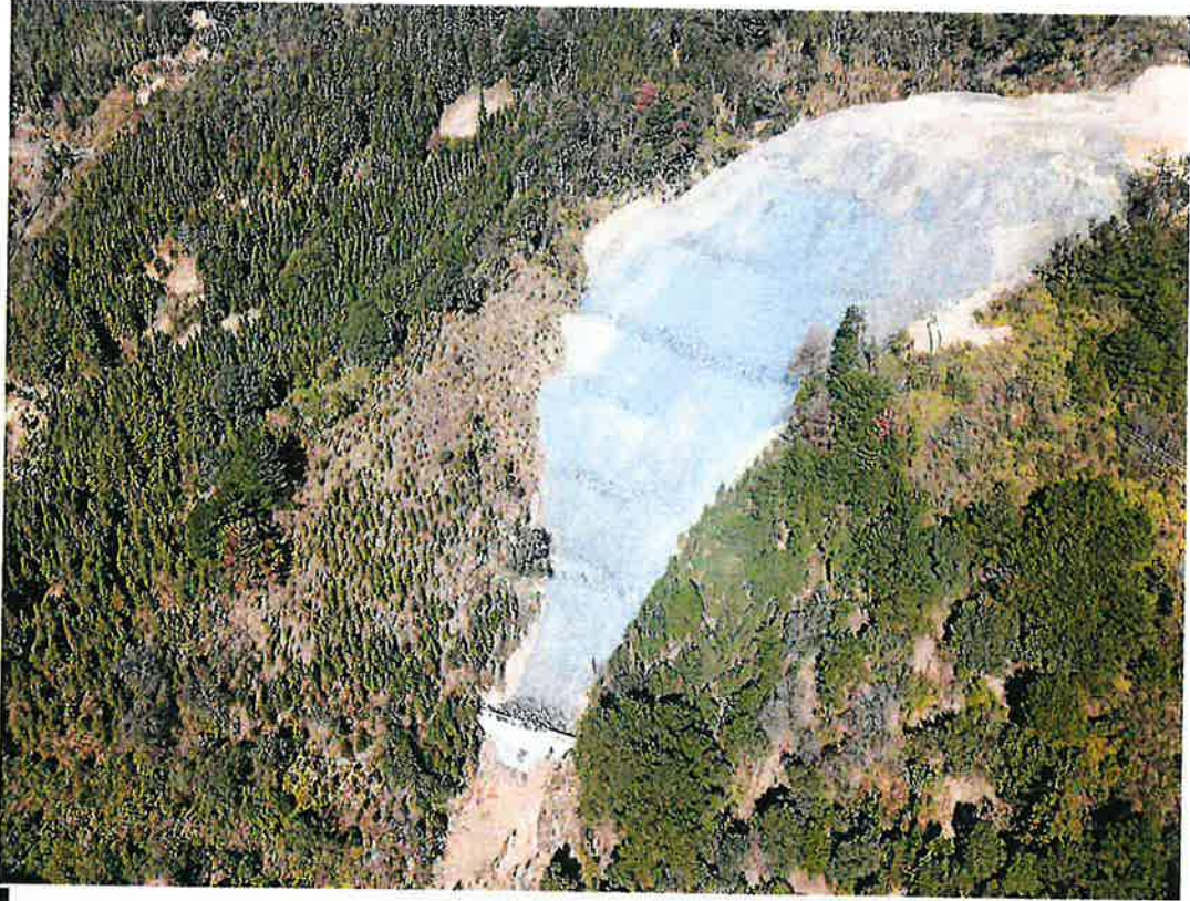
岩峰隧道进口弃渣场整改前现场照片
