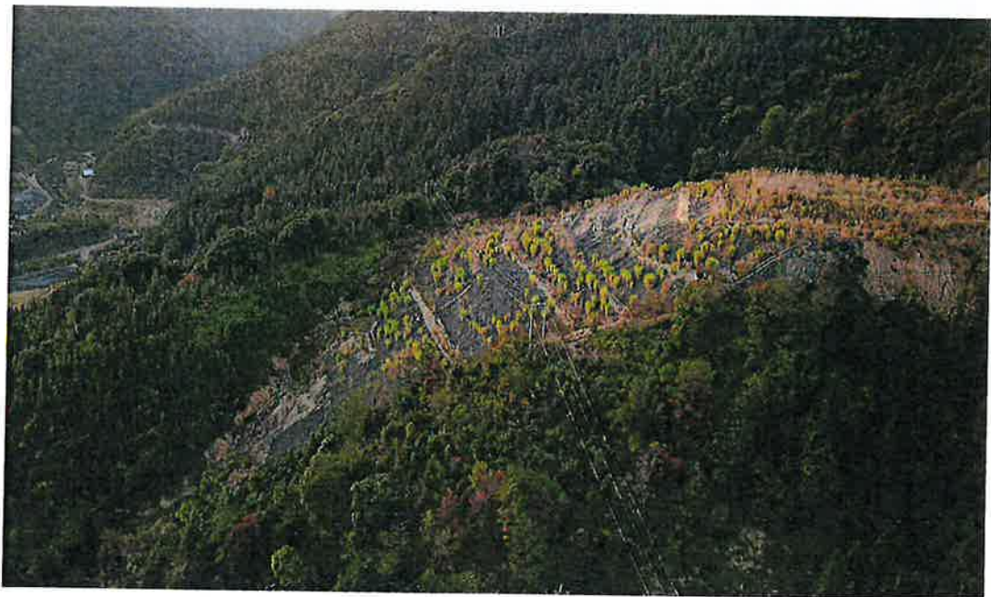
岩峰隧道进口弃渣场整改后现场照片
