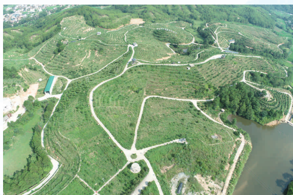
长汀县省级水土流失综合治理项目
