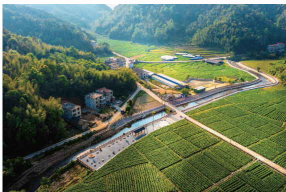
上杭县国家水土保持重点建设工程
