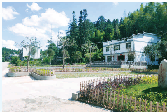
泰宁县水际村水土保持生态村建设项目
