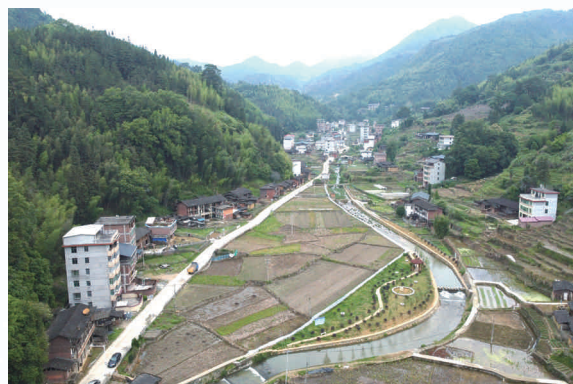
大田县桃溪小流域水土流失综合治理
