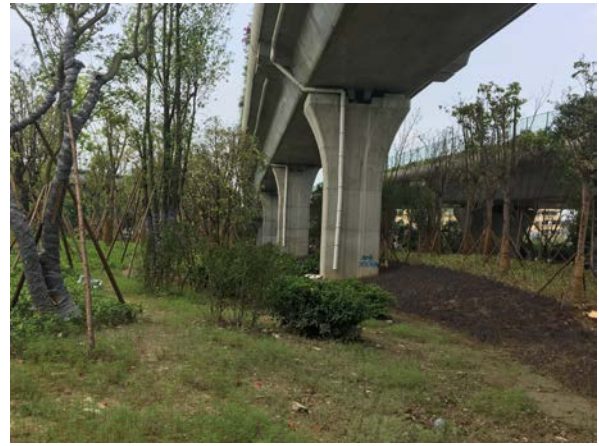
匝道桥下绿化现状 (2)
