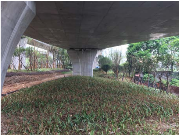
匝道桥下绿化现状 (1)
