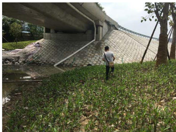
路基边坡及排水现状（2）
