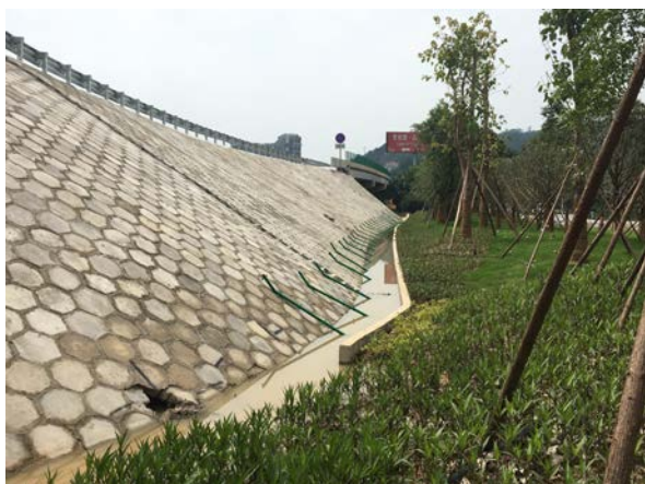
路基边坡及排水现状（1）
