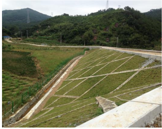
变电站护坡及排水沟
