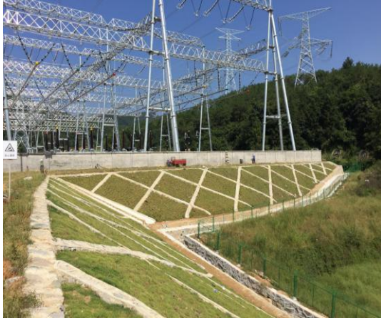
变电站护坡及排水沟
