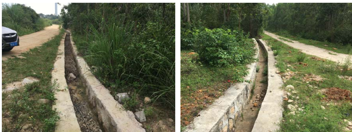
施工道路排水沟及绿化现状
