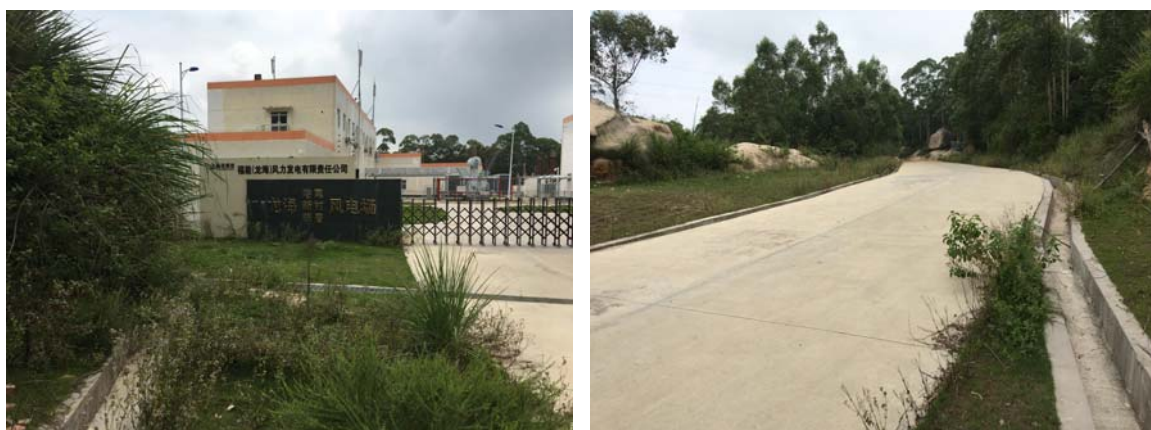
升压站排水沟及绿化现状
