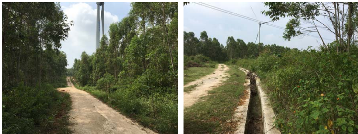
施工道路排水沟及绿化现状
