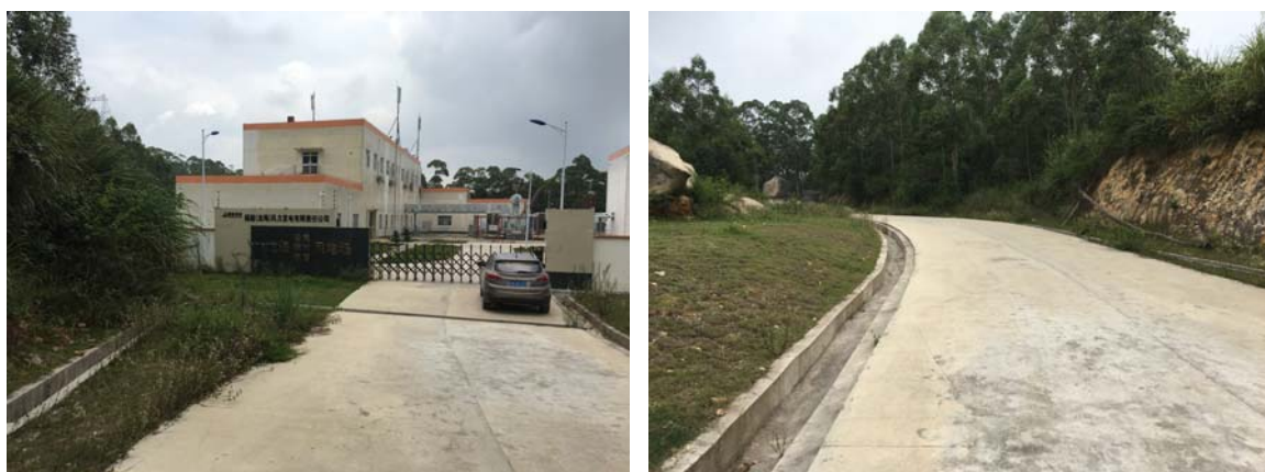
升压站排水沟及绿化现状
