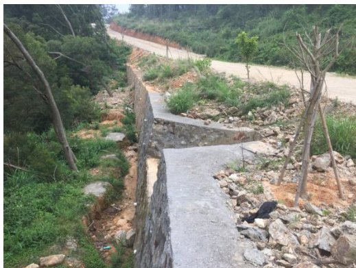
场区道路下边坡挡墙及沉砂池
