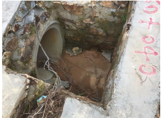
场区道路下边坡挡墙及沉砂池
